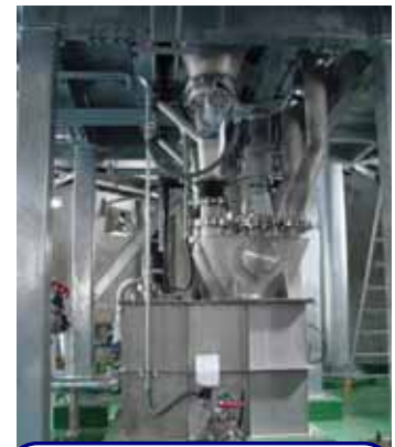
粉末活性炭注入設備
