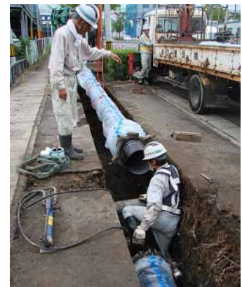
耐震管への更新工事
