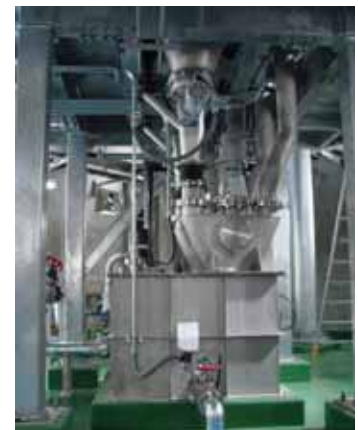
粉末活性炭注入設備
