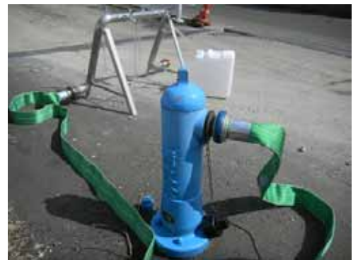
災害時給水栓
