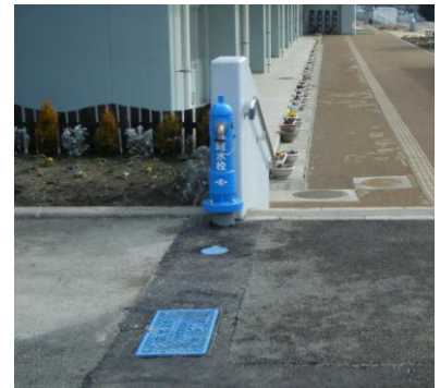
災害時給水栓
