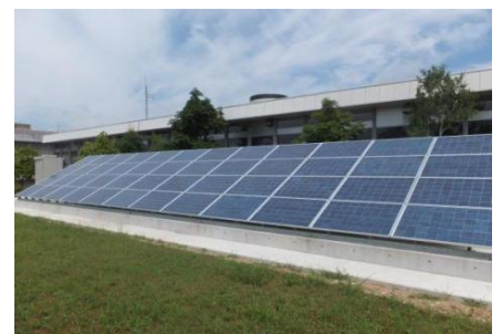
太陽光発電設備
