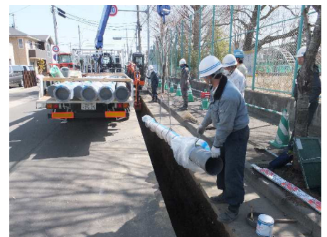
耐震管への更新工事
