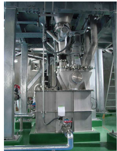
粉末活性炭注入設備
