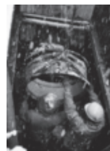
<震災時の復旧作業>
