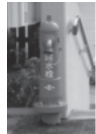
<災害時給水栓>
