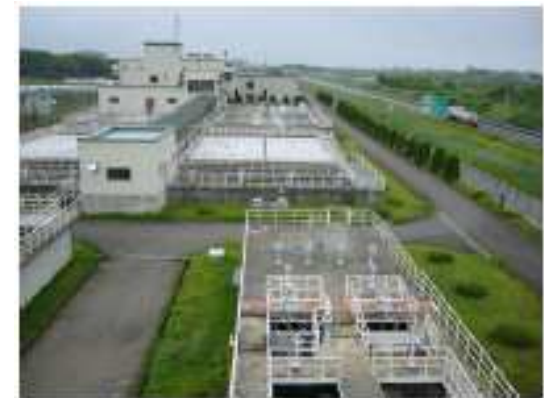
【廃止した富田浄水場】
