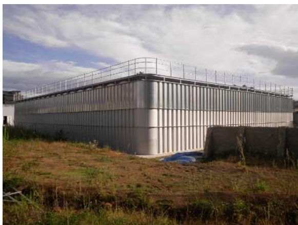
荒巻配水所 (2018年更新)
