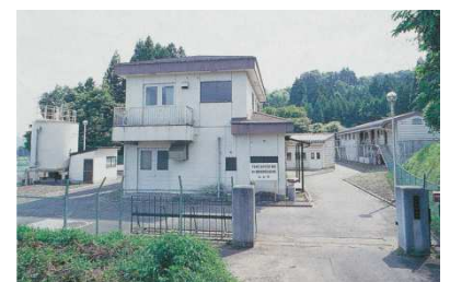
熊ヶ根浄水場
