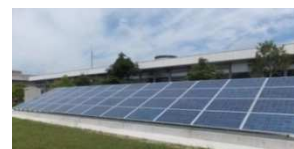
太陽光発電設備
