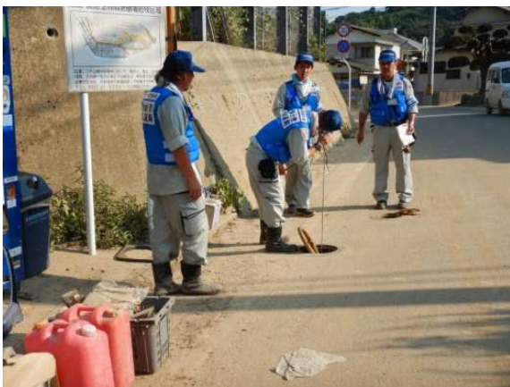
平成 30 年度西日本豪雨での漏水調査支援
