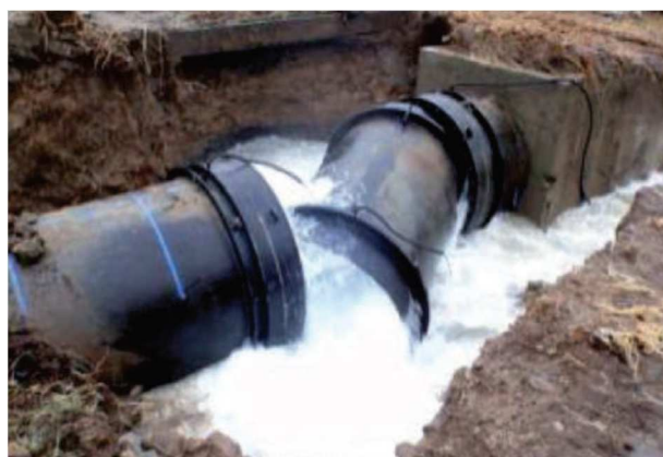
宮城県仙南・仙塩広域水道の破損（口径 2,400mm）
