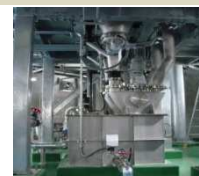
粉末活性炭注入設備
