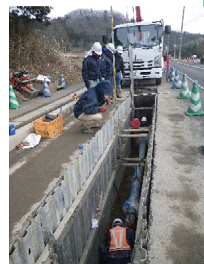
※管路布設状況
