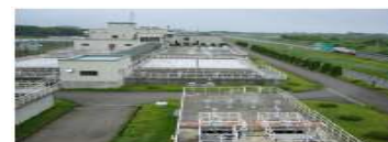
廃止した富田浄水場
