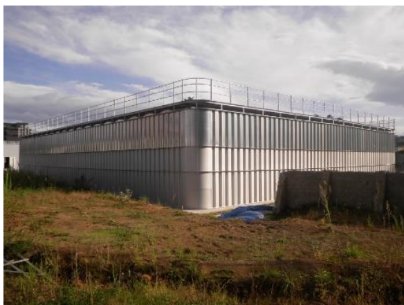
荒巻配水所 (2018年更新)
