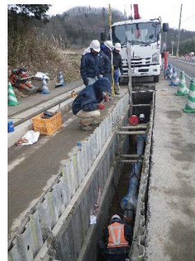
管路布設状況
