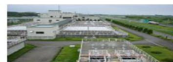
廃止した富田浄水場
