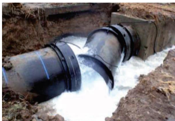
宮城県仙南・仙塩広域水道の破損（口径 2,400mm） (宮城県企業局提供)
