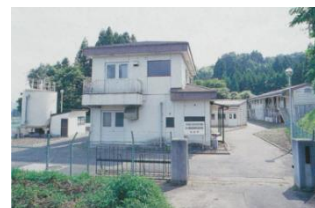
熊ヶ根浄水場
