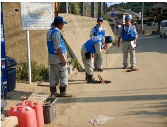
平成 30 年度西日本豪雨での漏水調査支援
