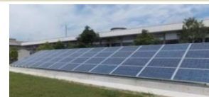
太陽光発電設備
