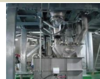
粉末活性炭注入設備
