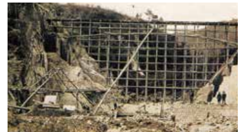
青下第二ダム建設の様子(第1次拡張事業)
