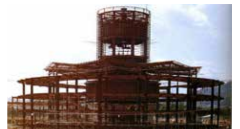
茂庭浄水場本館建設の様子(第4次拡張事業)
