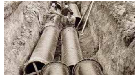
安養寺の送水管敷設現場(第3次拡張事業)
