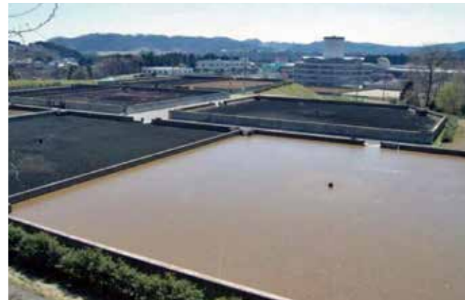
茂庭浄水場天日乾燥床 太陽のエネルギーで乾燥させる「天日乾燥方式」を採用し、エネルギー消費を抑えています。
