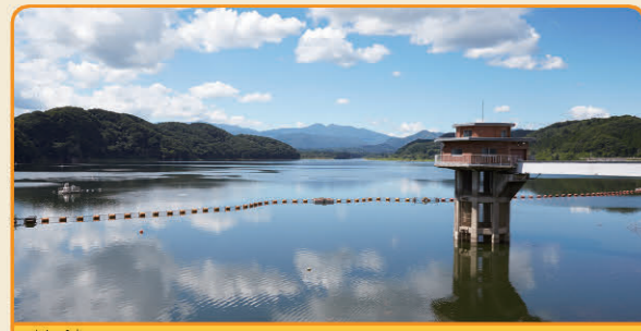
釜房ダム ●昭和45年完成 ●4,530万立方メートルの水をためることができます。
