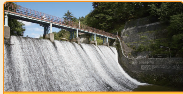
青下ダム ●昭和9年完成 ●59万立方メートルの水をためることができます。
