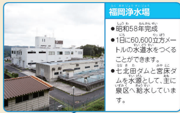
福岡浄水場 ●昭和58年完成 ●1日に60,600立方メー トルの水道水をつくる ことができます。 ●七北田ダムと宮床ダ ムを水源として、主に 泉区へ給水していま す。
