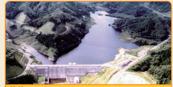
宮床ダム ●平成11年完成 ●540万立方メートルの水をため ることができます。
