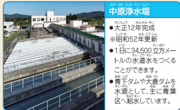
中原浄水場 ●大正12年完成 ※昭和52年更新 ●1日に34,500立方メートルの水道水をつくる ことができます。 ●青下ダムや大倉ダムを 水源として、主に青葉 区へ給水しています。
