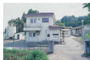
熊ヶ根浄水場
