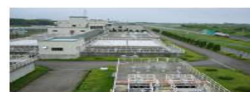
廃止した富田浄水場
