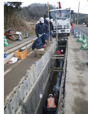
管路布設状況
