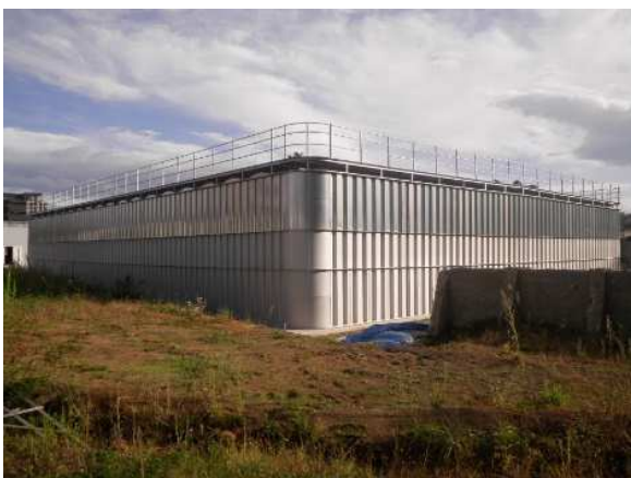
荒巻配水所 (2018年更新)
