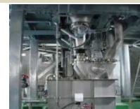
粉末活性炭注入設備
