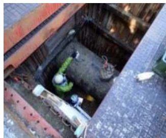
管体調査実施状況
