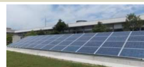
太陽光発電設備
