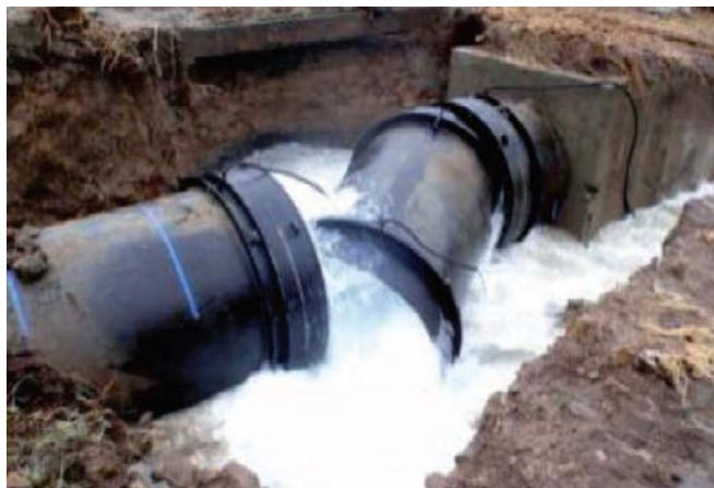
宮城県仙南・仙塩広域水道の送水管の破損（口径2,400mm） (宮城県企業局提供)
