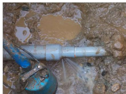
地震による老朽管の破損
