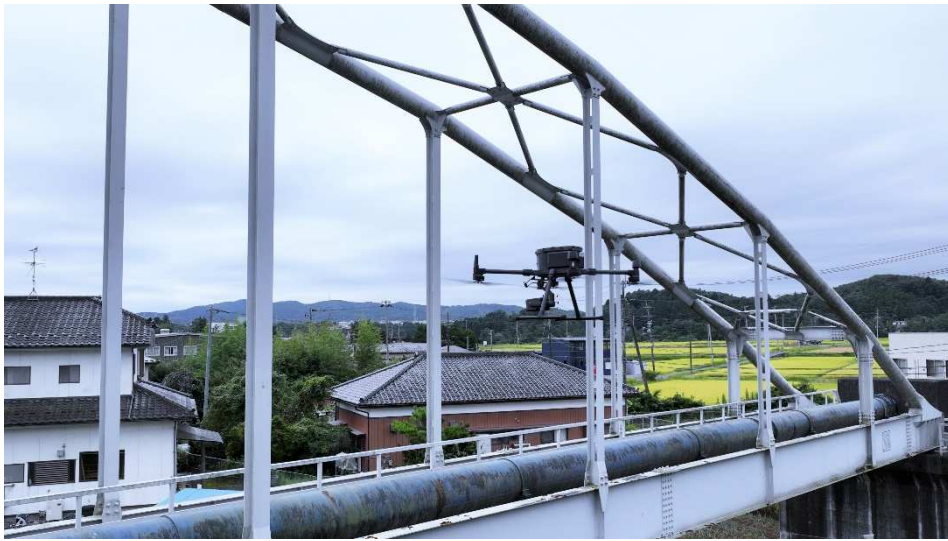
年川水管橋での実証実験の様子
