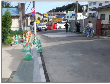
図 2.13 覆工板の設置状況
