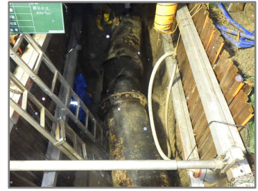
図 2.15 掘削完了状況
