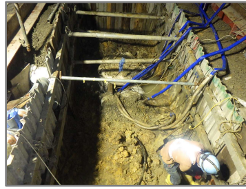
図 2.14 夜間掘削の状況
