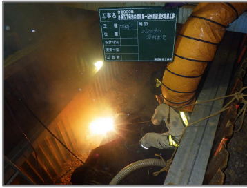
図 2.16 既設管のガス溶断状況
