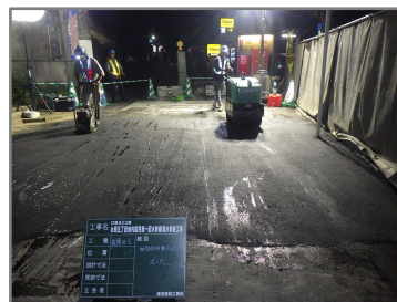
図 2.21 舗装版仮復旧の状況
