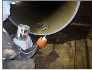
図 2.17 接続部の整形状況
