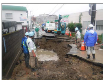
図 2.9 舗装版撤去状況
