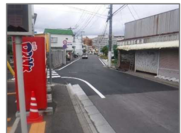
図 2.22 舗装版本復旧の状況
