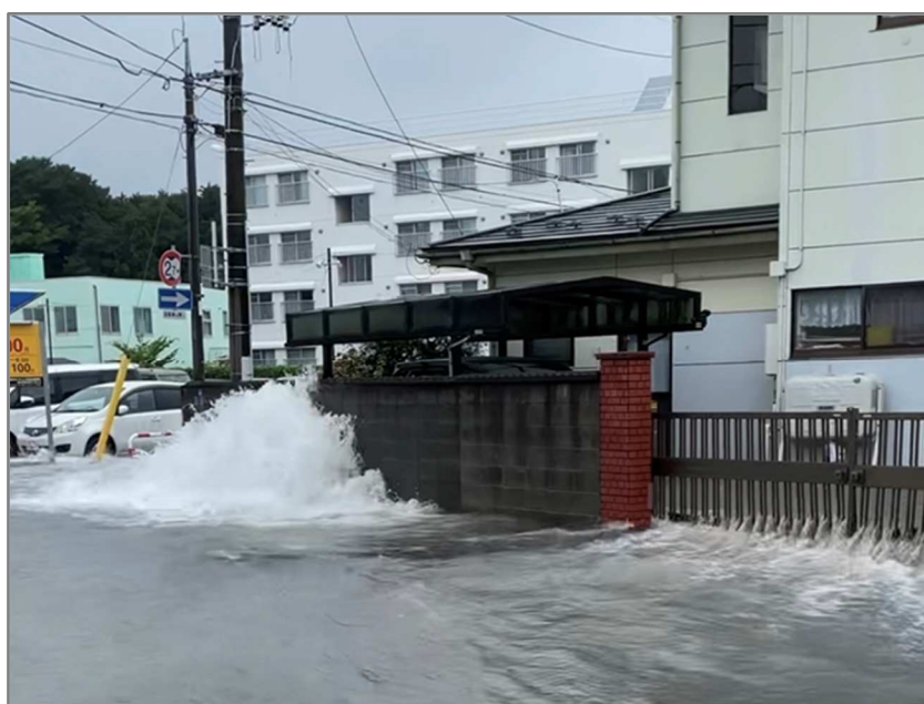
図 2.5 漏水箇所現場状況
