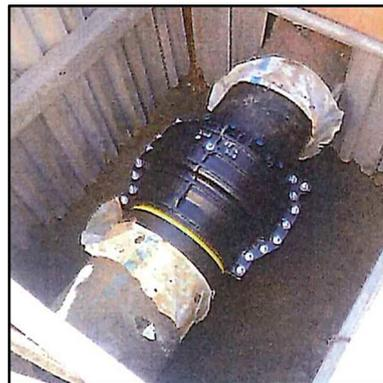
図 8.7 耐震継ぎ輪の設置状況 (写真は 500 mm 用)
