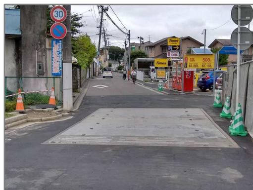
図 2.21 覆工板の設置状況
