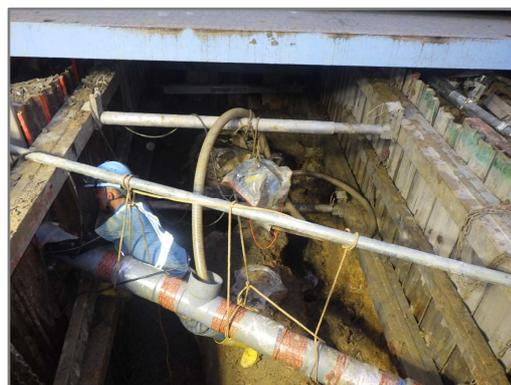
図 2.22 排水しながらの夜間掘削状況 (左: 8月1日、右: 8月3日)
