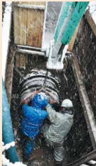
懸命な復旧作業(青葉区旭ヶ丘)
