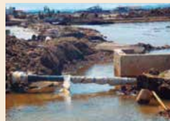
津波で道路が流されても残った耐震管(若林区荒浜)
