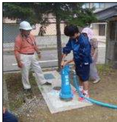
災害時給水栓の整備・操作方法の説明
