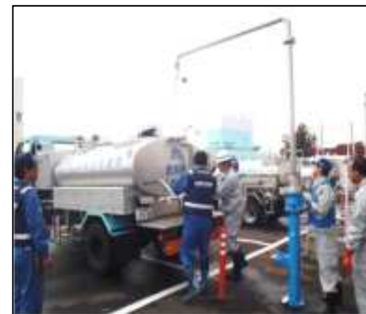
注水補給基地の整備
