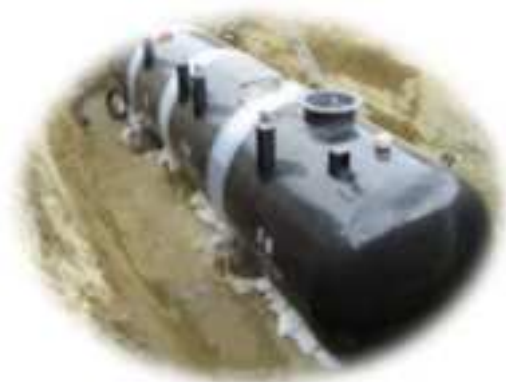
非常用飲料水貯水槽
