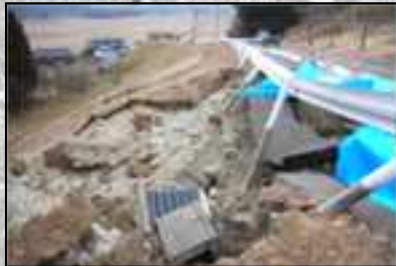
福岡浄水場進入路崩落
