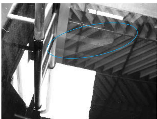
沈澱池傾斜板脱落状況
