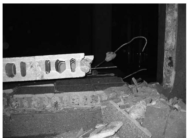
安養寺配水所導流壁倒壊状況
