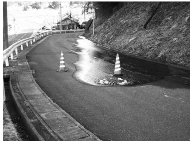
導水管空気弁の漏水状況
