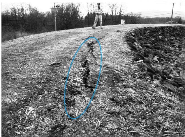
補充貯水池堤体亀裂発生状況
